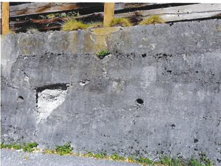
Particolare del degrado della corona e del muro, dove sono infissi i montanti in ferro della paratia.
