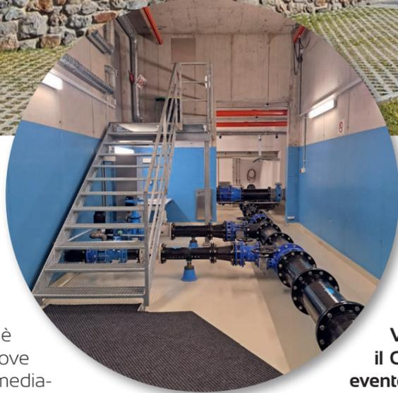
c'è il rivestimento di entrambe le vasche con il materiale "ETERTUB-Acqua", un polietilene in grado di proteggere la struttura dalla corrosione ed evitando la contaminazione dell'acqua stessa. Il nuovo locale saracinesche è stato dotato di telegestione, dove eventuali problemi sono immediatamente segnalati in maniera digitale all'Azienda Acqua Comunale. L'importanza di avere questo tipo di infrastrutture sempre aggiornate
